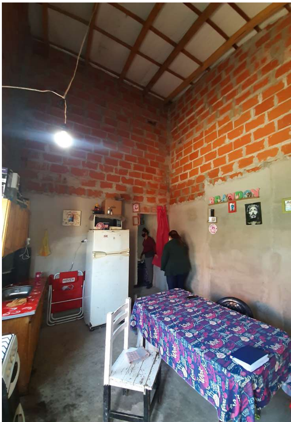
Barrio 23 de Diciembre, Moreno. El estudio verifica que los elementos componentes de cada unidad habitacional y la forma de ejecutarse son muy similares, predominando casi exclusivamente el uso de técnicas y materiales tradicionales.
